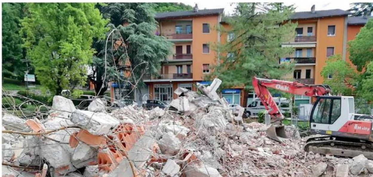
• La demolizione è in atto, nel sottosuolo sarà realizzato un parcheggio pertinenziale
